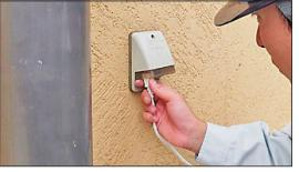
・センサーと受信ユニットの通信距離は見通し距離で**100m以内**です。建物の構造や送信機と受信ユニット間の障害物など周囲の環境によって短くなる場合があります。
